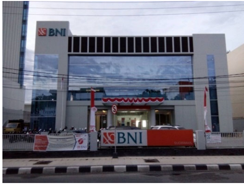
Rehabilitasi Exterior Gedung
