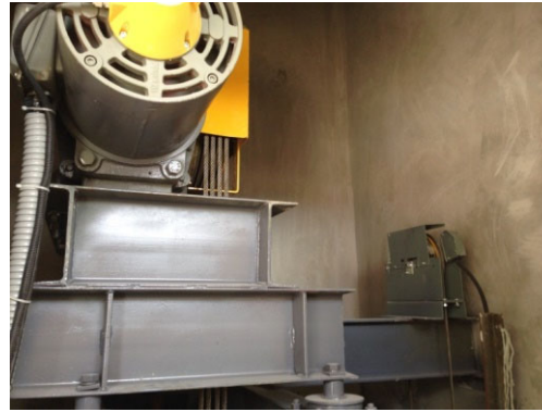
Pemasangan Mesin Lift Baru
